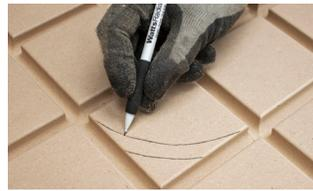
1. Tracez le contour d'une courbe douce en utilisant une longueur de tuyau ou un gabarit de courbe.
