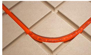
4. Essayez l'ajustement du chemin avec une section de tuyau avant de fixer le panneau sur le plancher.
