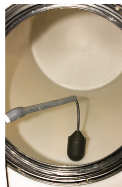
Interruptor de flotador instalado previamente
