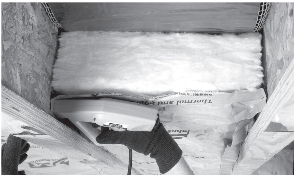
***RAPPEL: Il est nécessaire d'isoler et de sceller correctement l'espace entre les solives afin que le tapis UnderFloor fonctionne de manière satisfaisante.***
