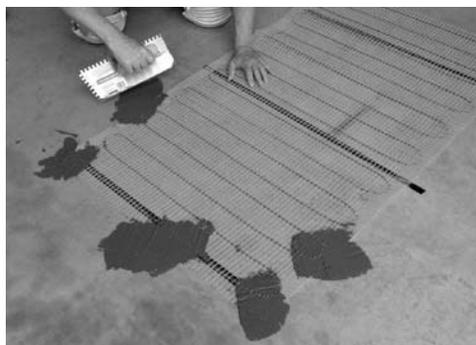
**Passages à la truelle à prise rapide aux coins et aux bords du treillis pour le fixer au plancher.**
