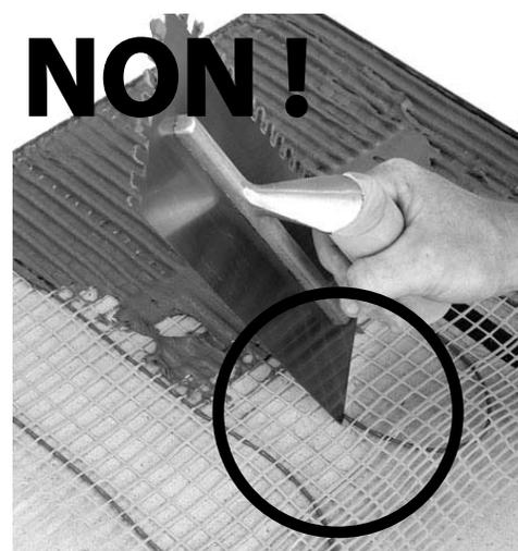
**NE JAMAIS** frapper une truelle sur le treillis ou le câble chauffant pour retirer le surplus de mortier de la truelle. Le câble chauffant pourrait être endommagé ou coupé de cette manière.
