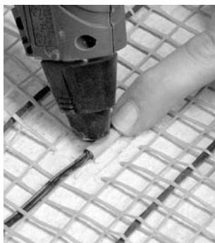
**Pour mettre le capteur en retrait dans le plancher, découpez une petite section de la maille du treillis et burinez une poche peu profonde pour le capteur. Enflez le câble du capteur de 6 à 12 po (30,5 à 61 cm) dans le tissage du treillis et au centre du bout du capteur exactement entre deux des câbles chauffants. Collez à la colle chaude le bout du capteur en place.**
