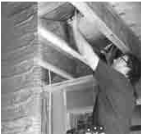
Pruebe encajar la placa entre las vigas antes de sujetar la placa a ellas con ayuda de grapas.
